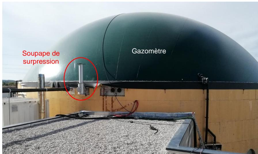
Figure 8 : Gazomètre et soupape de surpression
